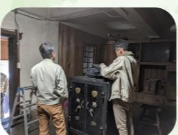
内部には今ではなかなかお目にかかる珍しいものが多く残っていました。まずはそれらの整理を行い、ものがなくなると内部がだいぶ広く感じられます。次に解体工事で新建材の部分を剥がしていきます。外部の解体が終わるとこの蔵の特徴でもある金庫のような入り口の扉が見えるようになりました。内部は造りつけの収納を一部残しつつ解体し、床を補修します。こちらの補修もあるべく解体で出た木材を使いながら既存部分と比べて浮いてしまわないように行っています。どの様なカフェになるのかお楽しみに！
